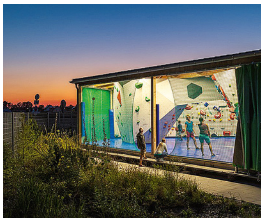
Die Boulder-Anlage des neuen Alpinzentrums in Erding.
